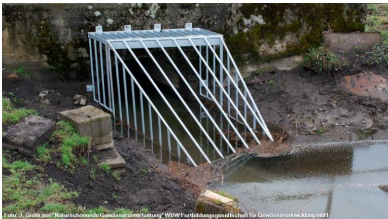
Räumliche Rechen als Schutz vor Verklausung
