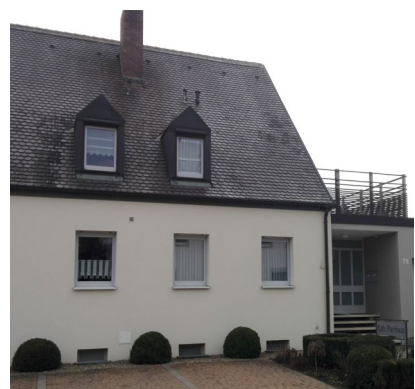
Abb.23: Neu saniertes Gebäude: Kath. Pfarrhaus, Sambach 79
