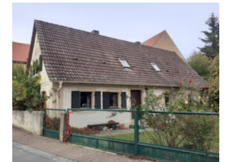
Abb.22: Mittlerer Gebäudezustand, Steppach 91
