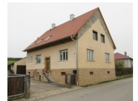
Abb.23: Umbau-/ Modernisierungsmaßnahmen an Wohngebäude, Steppach 47
