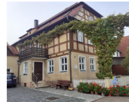
Abb.18: Ehem. Färberei, 1. Hälfte des 18. Jh., Steppach 85
