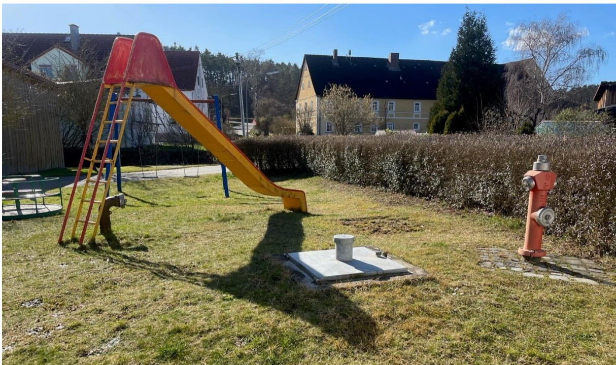
Löschwasserentnahmestelle: Unterköst (75 cbm)
